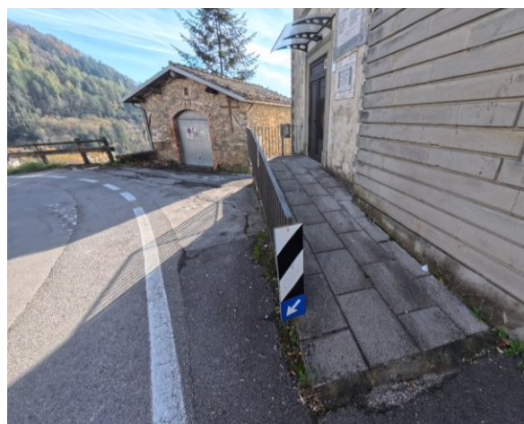
20 Rampa per accesso municipio
